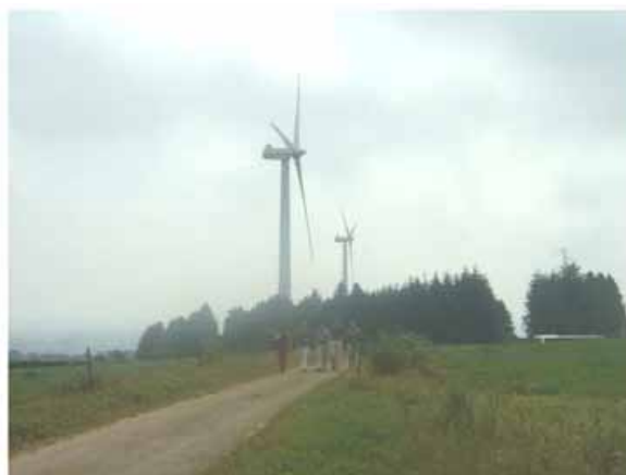
Visite d'un parc éolien
