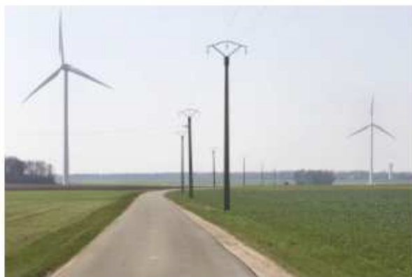
Parc éolien et lignes électriques
